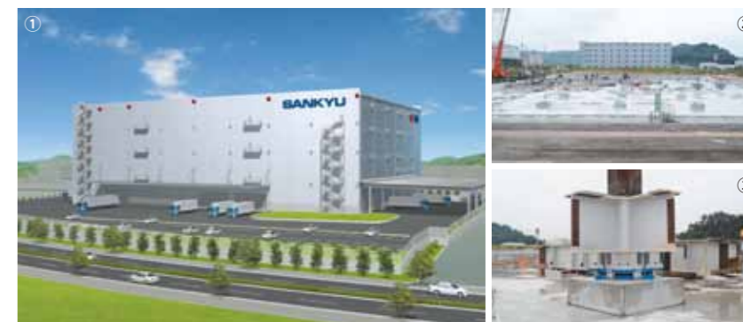
①神戸市が整備を進める「神戸テクノ・ロジスティックパーク」内で建設中の「(仮称)西神戸物流センター」の完成予想図 ②「NS-SSB」を設置した免震層全景 ③「NS-SSB」上への柱の建て込み(立柱)
