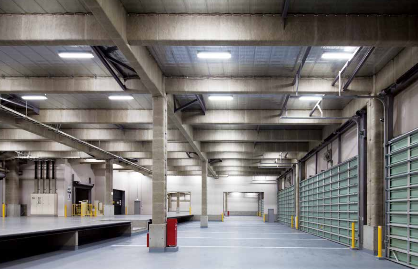
4階トラックバース
