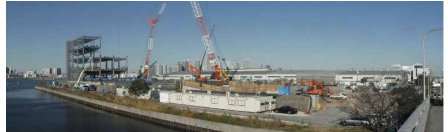
施工中の様子
