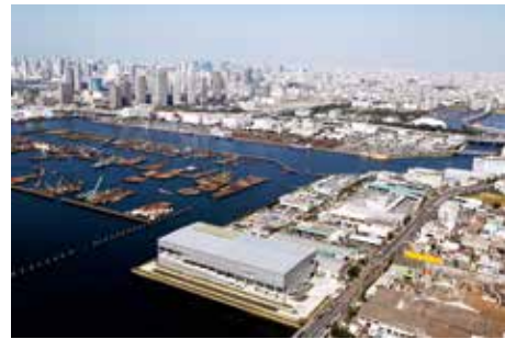
上/事務室内部 中/4階倉庫内部 下/空撮(南東)
