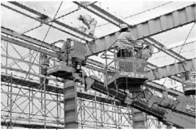
鉄製の柱と屋根を支える「ハリ」。重さを3割軽くした「宇都宮市の建設現場」
