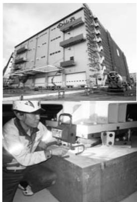
工事が進む西神戸物流センター①と新免震装置施工
