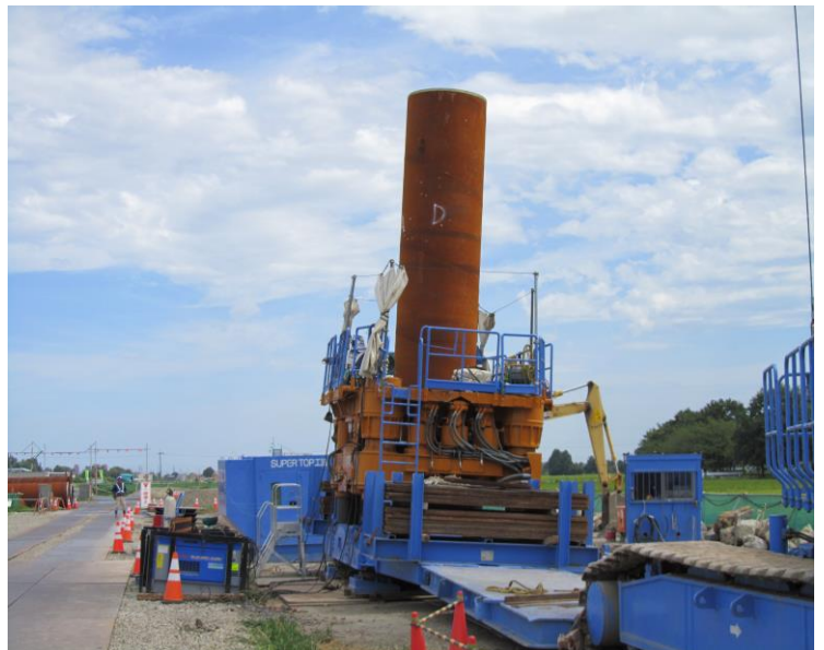
【斜杭施工の様子】
