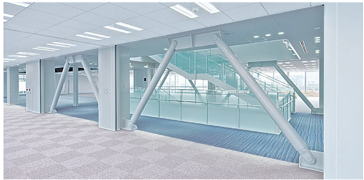
超高層建物の制振部材から中低層の耐震用途まで多様な施設に適用される「アンボンドブレース」
