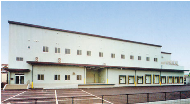
鉄骨重量を約30%削減する「SPウェーブフレーム」。下は施工事例の冷凍冷蔵庫。外観デザインやカラーの自由度も高い
